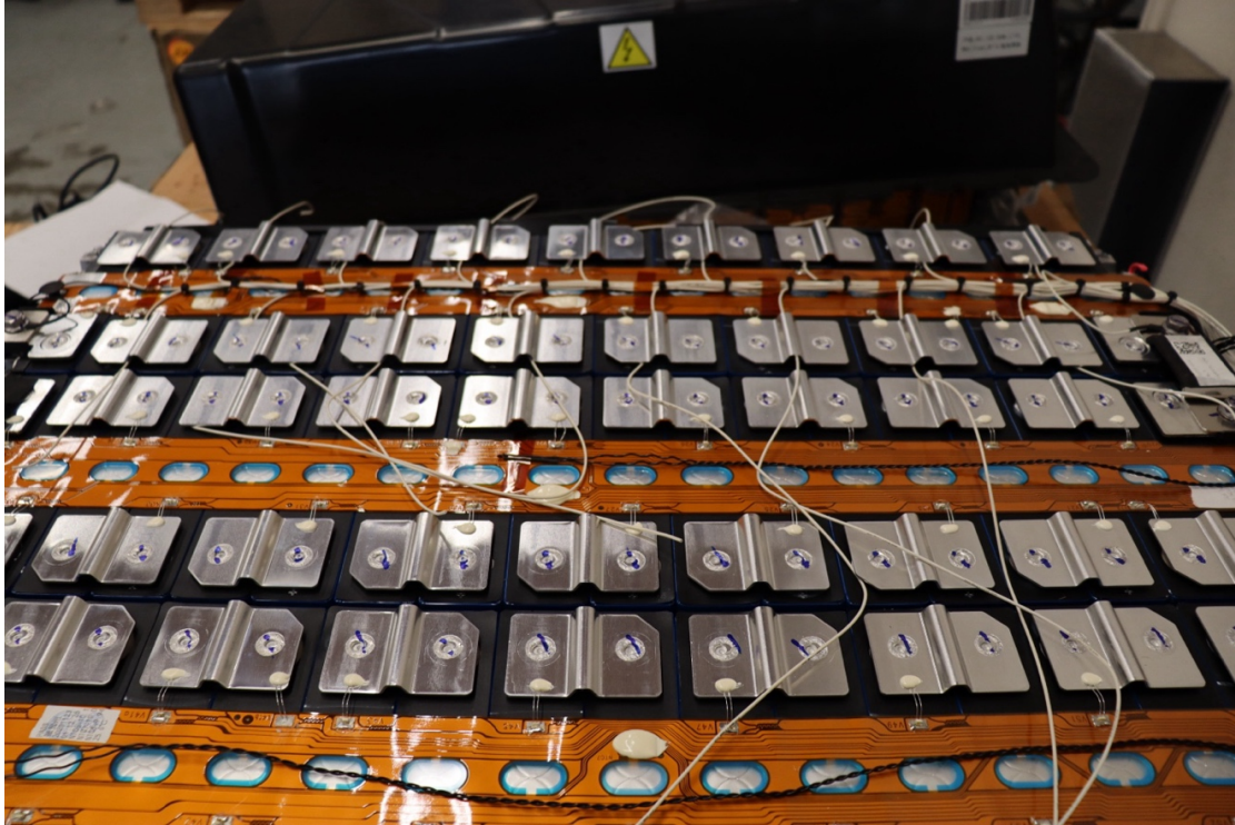
#) Route wires to cells
